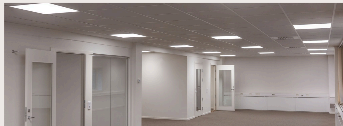
Biobaserad belysning i kontorsfastigheten Stolpen 1 i Karlstad.
