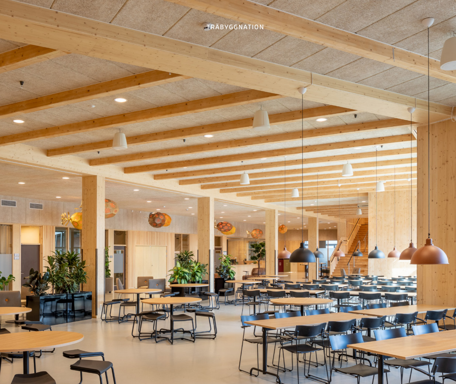
↑ HEMLINGBORG I skolans matsal har väggpartier i KL-trä lämnats synliga och träkänslan är påtaglig.
