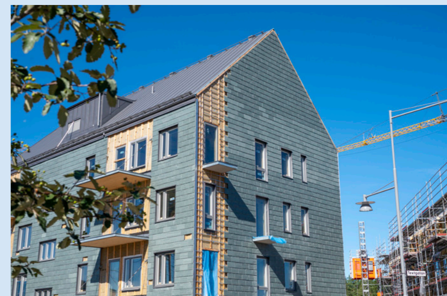
← SÖDRA HEMLINGBY Fasaderna är täckta med skiffer. Ett nytt fasadmaterial för Gavlegårdarna och ByggPartners snickare.
