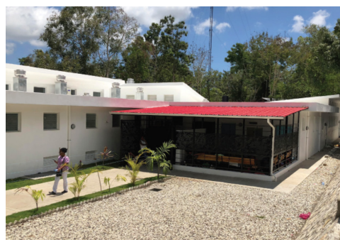
Microdesk har medverkat vid utformningen av mödravårdsmottagningen vid Koidu Government Hospital i Sierra Leone. Designen har bidragit till besparingar vad gäller material, energi, tid och kostnader, samtidigt som högkvalitativ vård uppnås med bättre hälsoreultat som följd.
