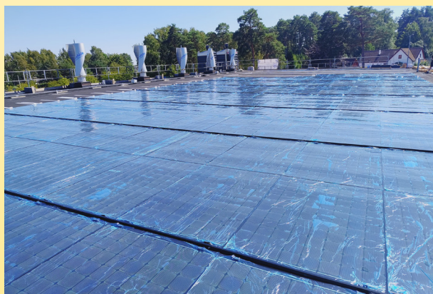
Ett 676 kvadratmeter stort solcellstak på Blentarps sporthall i Sjöbo.
