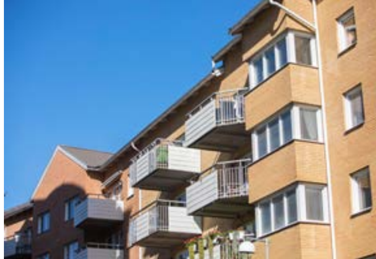
Postmästaren 2, Nynäshamn. 80 apartments, 18 premises.
