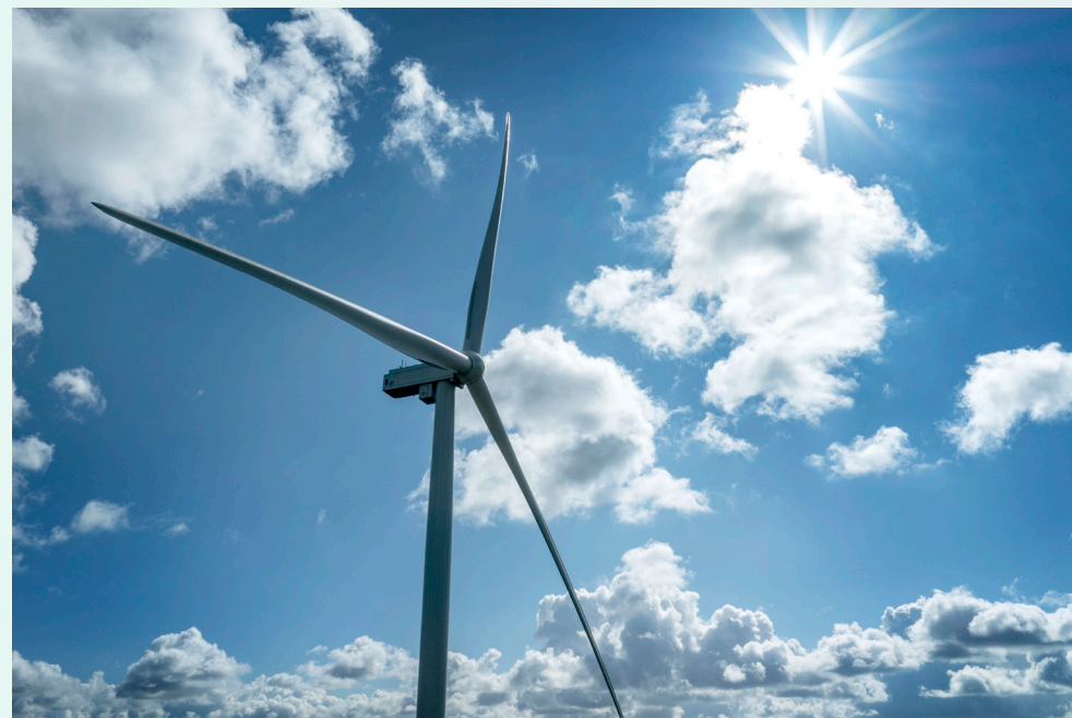
Tjärnäs Wind Farm
