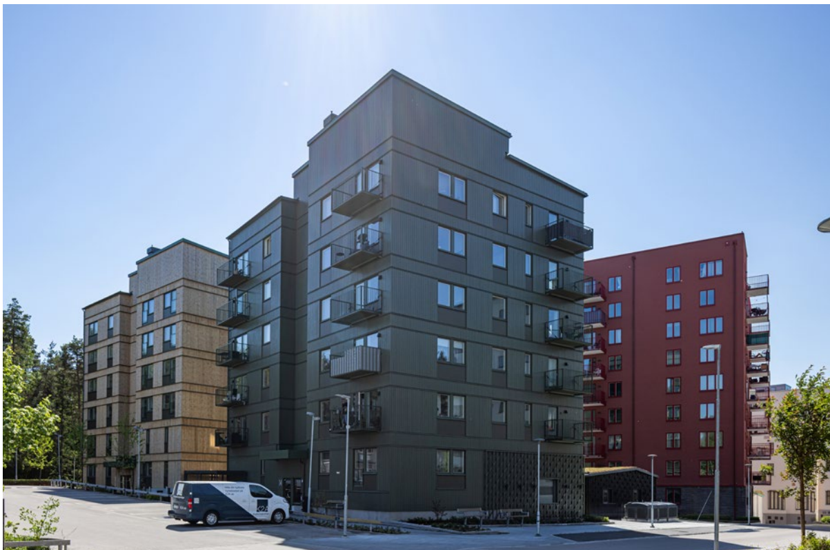
I det natursköna området Fredriksberg i Västerås ligger K2A:s 62 hyresbostäder, färdigställda under första kvartalet 2024. Fastigheten gränsar till skog och rustade skogsstigar och ligger endast 3,5 kilometer från Västerås Centrum. Projektet är uppfört i svenskt certifierat trä och miljöcertifierat enligt Svanen.
