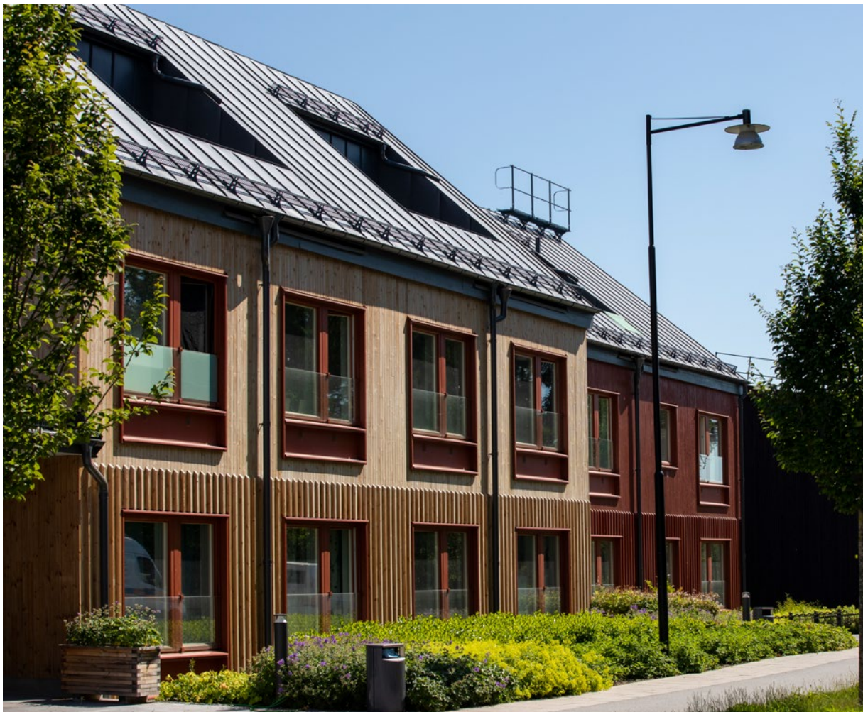
K2A:s bostäder i Vega Park i Haninge byggdes i tre etapper, där den sista etappen stod klar 2020. Området omfattar totalt 462 hyresbostäder med 1–3 rum och kök.
