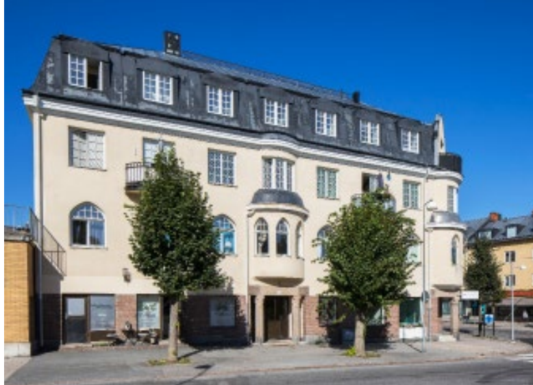
Postmästaren 2, Nynäshamn, 80 apartments.
