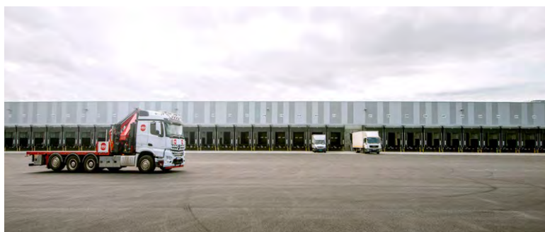
I direkt anslutning till E6, strax söder om Oslo, ligger DSVs nya anläggning.
