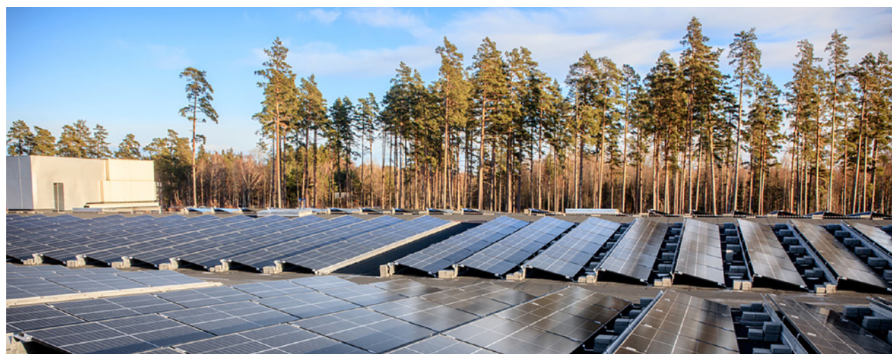
Solpanelerna hos CTT Nybro driftsattes i slutet av 2021 och producerade ca 200 000 kWh under år 2024. Enligt förväntan som var på 200 000 kWh.
