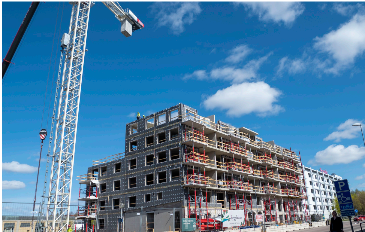
Stomresning under bostadsprojektet Sågklingen för SBB i centrala Västerås.
