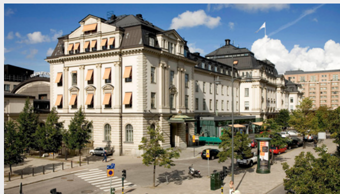
Jernhusen hanterar all sin byggnadsinformation ur ett livscykelperspektiv med hjälp av Service Works Globals fastighetssystem. På bilden Jernhusens fastighet Stockholm Centralstation.
