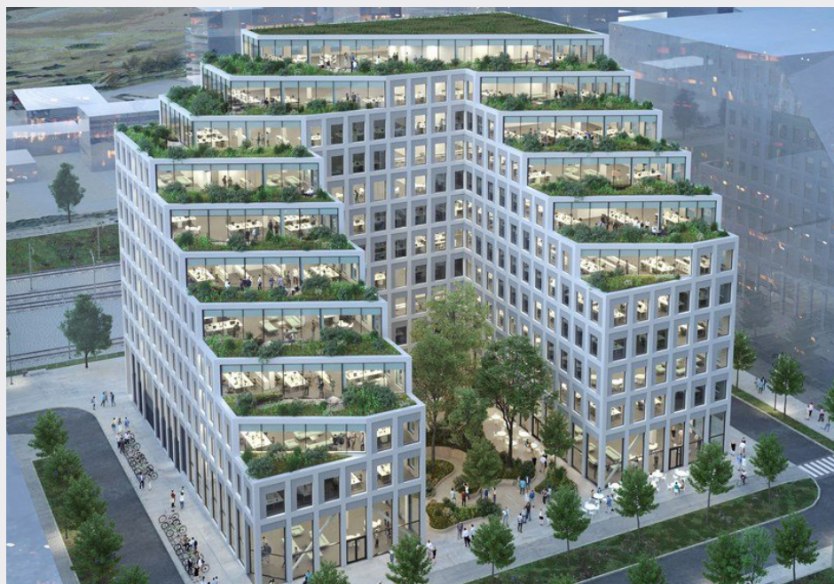
Skanskas projekt Hyllie Terrass i Malmö är en miljöcertifierad byggnad som använder Tribias dokumentationslösningar. Tribia är ett av Addnode Groups dotterbolag som ingår i division Design Management.
