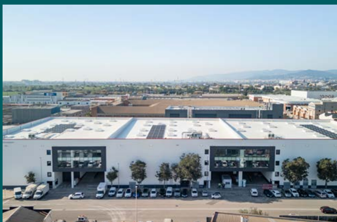
Solceller på Femades 37, Barcelona, Spanien. Fastigheten är certifierad enligt BREEAM Excellent och har en energiklass (EPC) B.
