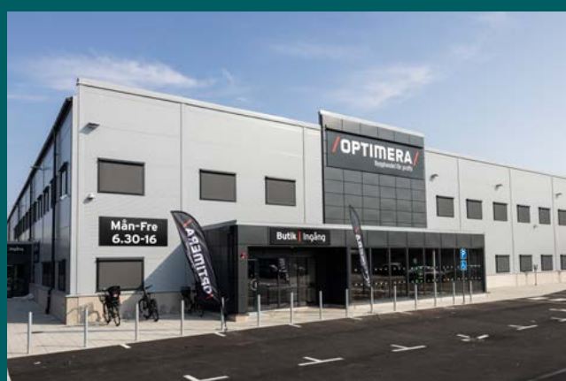
Nybyggnation på fastigheten Bredablick 4, Malmö, Sverige. Fastigheten certifieras enligt Miljöbyggnad Silver och förväntas erhålla energiklass (EPC) B.
