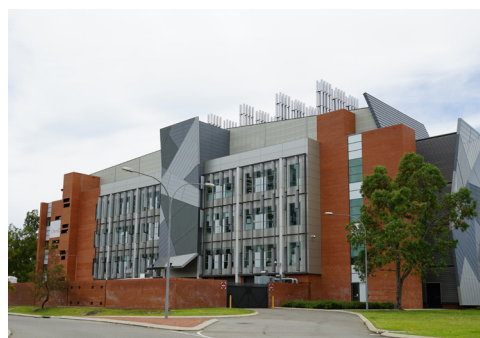
Service Works Global har levererat sitt digitala system för fastighetsförvaltning, QFM, till Curtin University, Australien. Det nya förvaltningssystemet bidrar till att universitetet även fortsättningsvis kan åtnjuta erkännanden för sina ambitioner inom innovation och hållbarhet.
