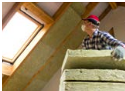
Holmströmgruppen arbetar löpande med att tilläggsisolera fastigheternas vindar.
