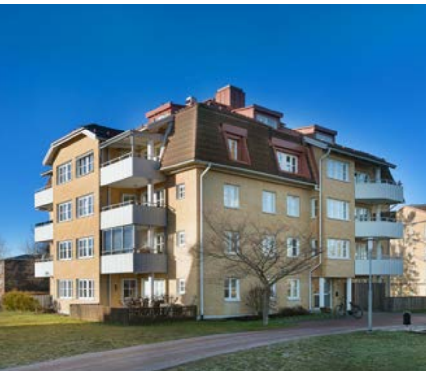
Rapsen 6 är en av de fastigheter som förvärvades i Kalmar under 2022.
