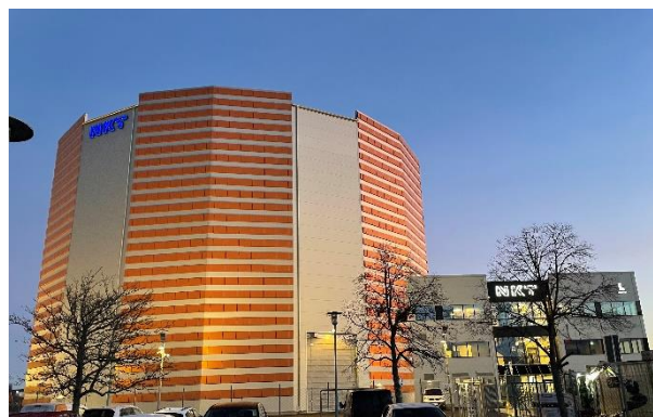
Färdigställd test- och produktionshallen i Alingsås i december 2024
