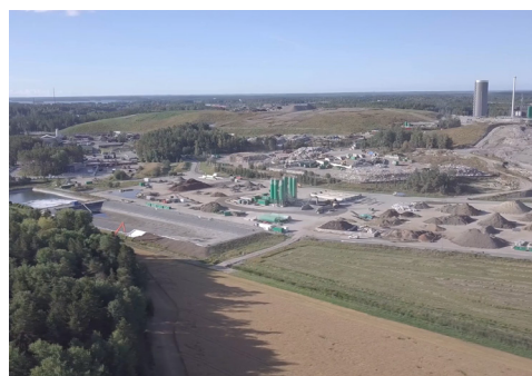
Sokigo har levererat lösningarna TopoCad och CSM till miljöföretaget Ragn-Sells. Systemet möjliggör snabbare och mer effektiv utformning av Ragn-Sells återvinningsanläggningar vilket bidrar till bättre och säkrare återvinning och avfallshantering.
