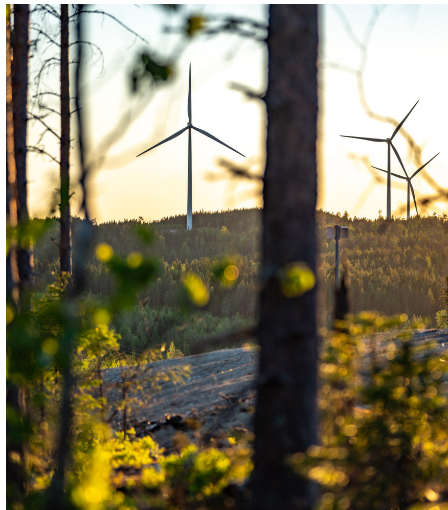
Vindpark Nylandsbergen i Sundsvalls kommun med 18 vindkraftverk, totalt 68 MW, färdigställdes 2019.
