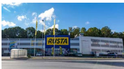
Fastighetsbeteckning: Kumlaknekten 2 Region: Stockholm Uthyrningsbar yta: 2 372 kvm
