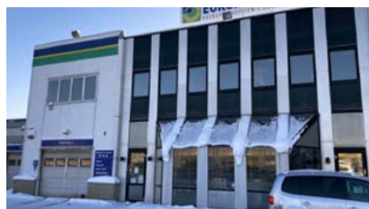
Fastighetsbeteckning: Slipskivan 1 & 2 Region: Stockholm Uthyrningsbar yta: 1 475 kvm
