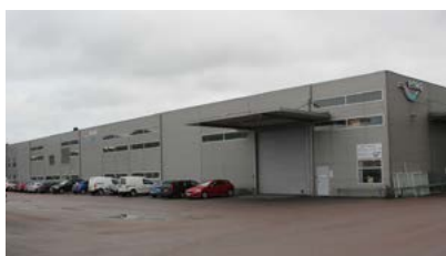
Fastighetsbeteckning: Backa 27:1, 27:48 & 866:771 Region: Göteborg Uthyrningsbar yta: 13 831 kvm
