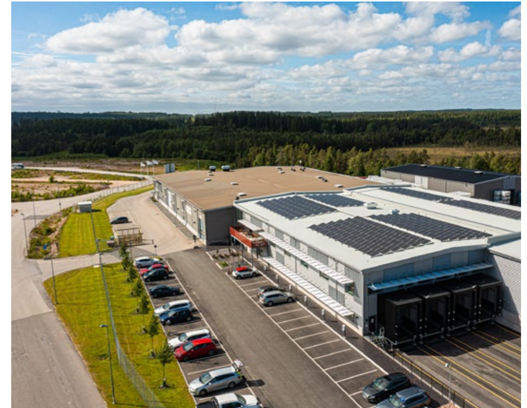
Fastigheten Lockryd 2:76 → med solcellsanläggning.
