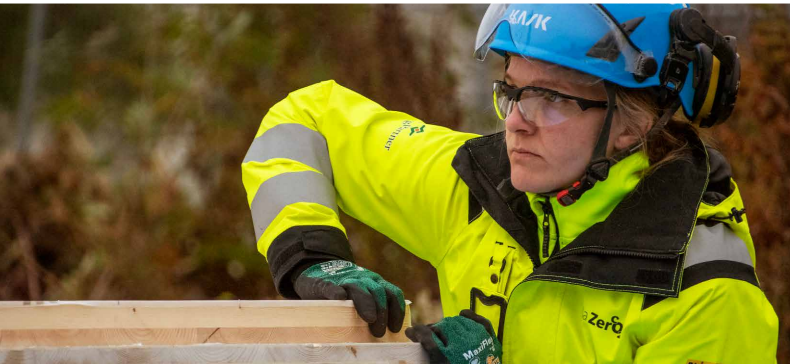
† Hantverkare Sofie Törnblom under stomresning av Villazero i Borlänge. Huset byggs helt i trä och certifieras enligt Svanden och NollCo 2 .
