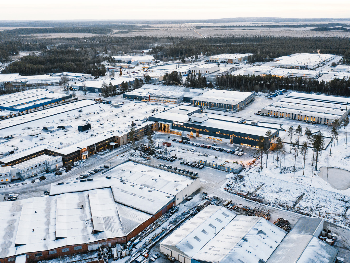
Thule Group globala utvecklings- och testcenter samt takräckesfabrik i Hillerstorp, Sverige.
