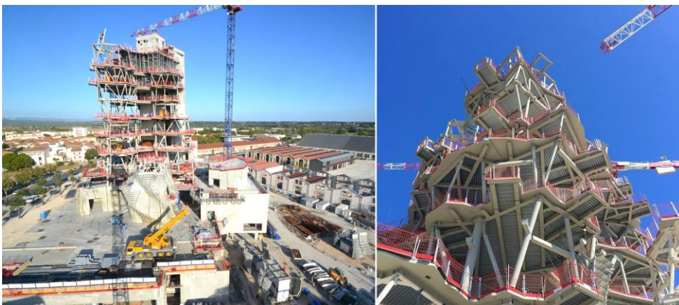
Novakort Systems säkerhetslösningar vid byggnation av Luma i Arles, Frankrike.
