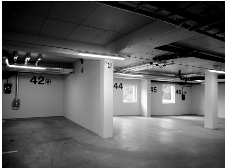
Garage med laddningsmöjligheter, Vårbergstoppen, Vårberg
