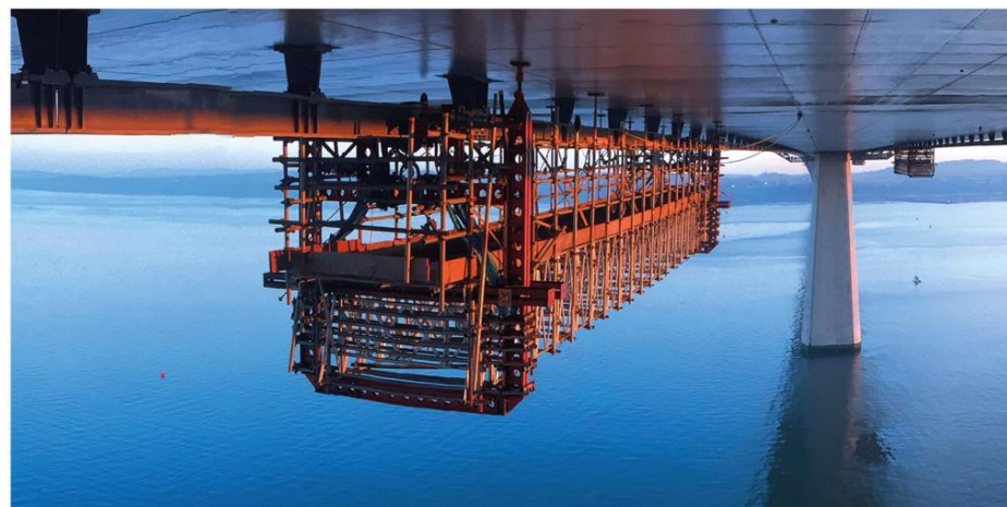
HAKI Access systemlösningar i samband med brorenovering.
