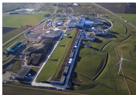
ESS, European Spallation Source i Lund, Sverige, är ett multidisciplinärt forskningscenter baserat på världens mest kraftfulla neutronkälla. TECHNIA stödjer ESS i etableringen av en digital tvillingmodell som hanterar design-, bygg- och driftsättningsfaserna på ett effektivt och helt spårbart sätt. I slutet av användningsperioden möjliggör detta också en ekologiskt ansvarsfull avveckling av hela anläggningen. Foto: Perry Nordeng/ESS.
