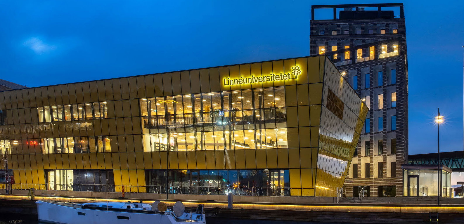
Det nybyggda universitetsbiblioteket i Kalmar, beläget på Universitetskajen i centrala Kalmar. P&E Persson har sedan 2012 arbetat med etableringen av den västra etappen av Linnéuniversitetets satsning i Kalmar, och 2019 stod byggnaderna klara. Foto: Linnéuniversitetet.
