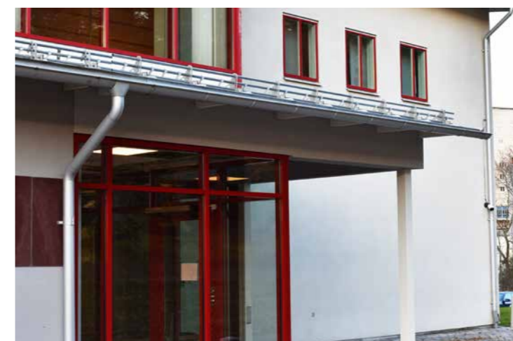
† Tingsrättsbyggnadens nya, säkra entré.
