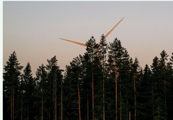
Vindkraftsprojektet Fageråsen, som i juli såldes till OX2, är i sen utveckling och omfattar upp till 34 vindkraftverk. Eolus och Dala Vind har gemensamt utvecklat projektet som utgör en viktig pusselbit i Dalarnas energiomställning.
