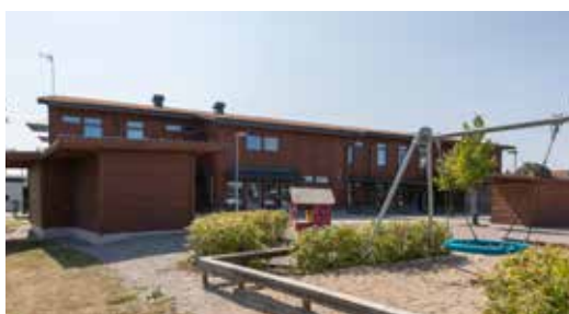
Växthuset 1, Norrköping (pre-school).
