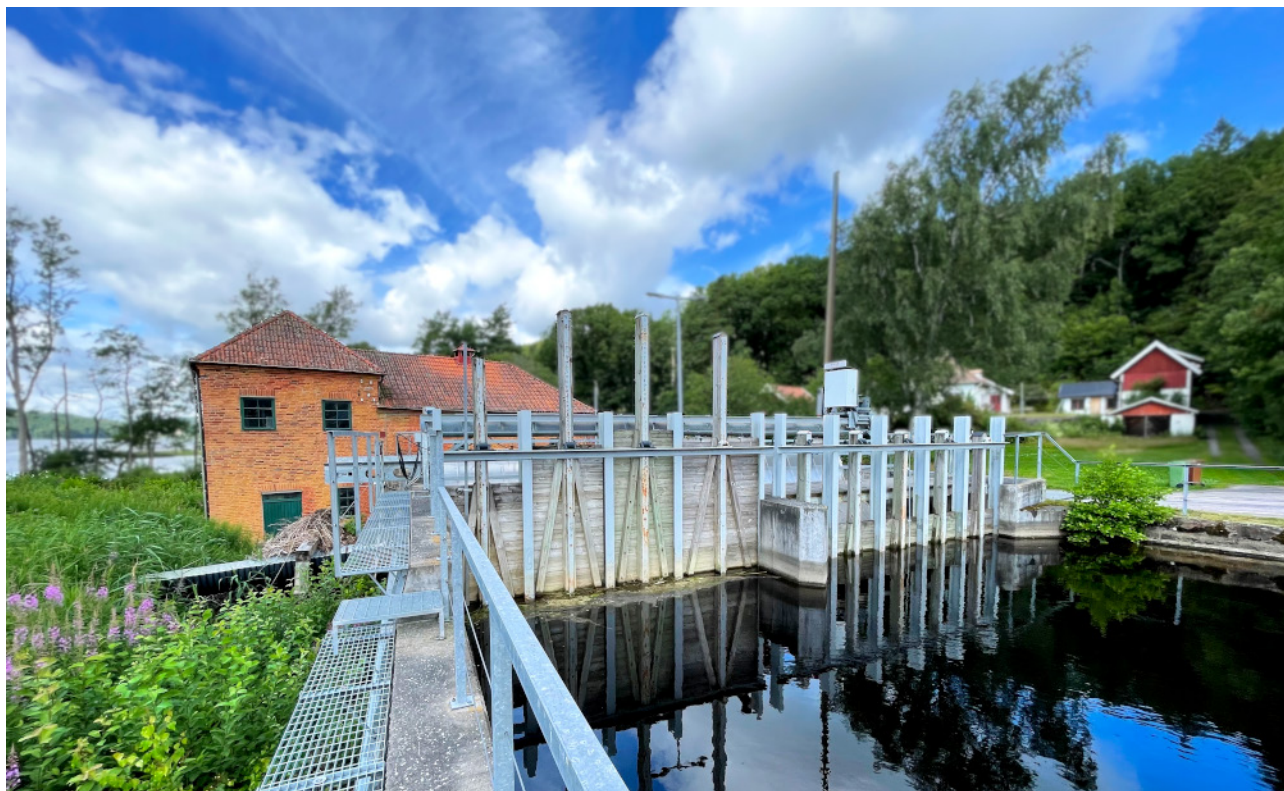
Algårda vattenkraftverk i Kungsbacka
