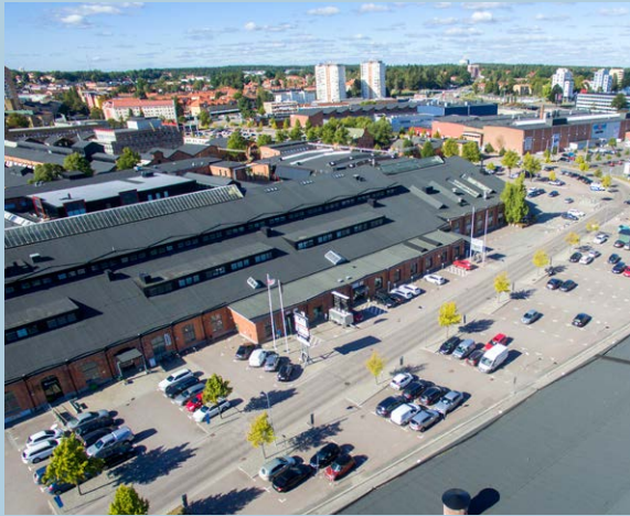
Kontorsfastigheten Verkstaden 6 i Västerås.
