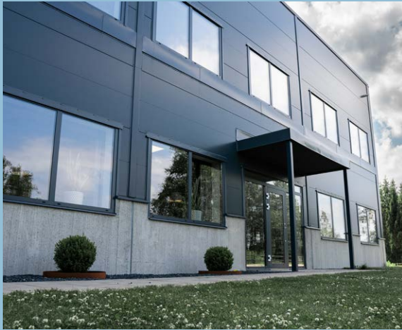
Lagerfastigheten Slangbellan 3 i Värnamo.
