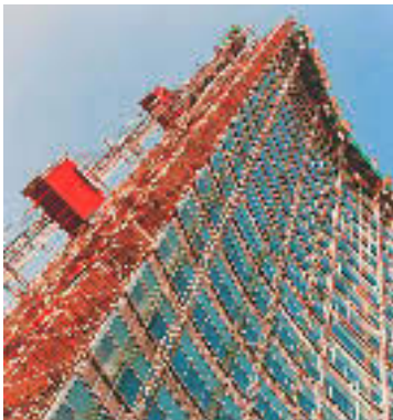
Utrustning från Alimak Hek används vid byggandet av kontorshuset Zuidtoren i Hoofddorp, Nederländerna.
