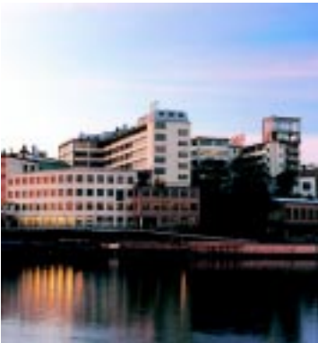
I bästa läge i Hammarby Sjöstad ligger Luma. Funkisbyggnaden är renoverad invändigt och erbjuder moderna kontor.
