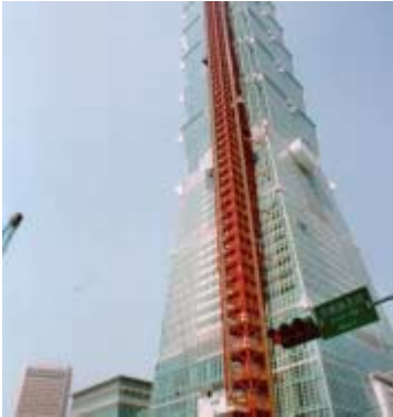
Alimak's utrustning används vid byggandet av världens högsta byggnad, Taipei Financial Centre i Taiwan.
