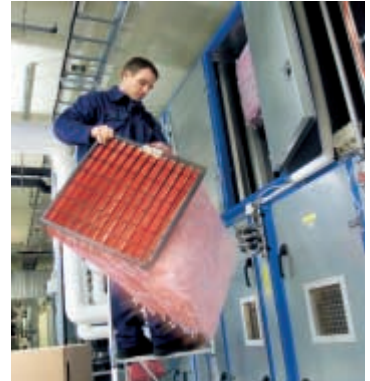
Byte av luftfiltret Hi Flo som är Camfils största produkt.
