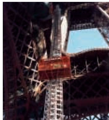
Alimak levererade hisslösningarna när Eiffeltornet renoverades.
