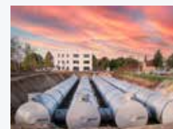
Olje- och sandseparator
