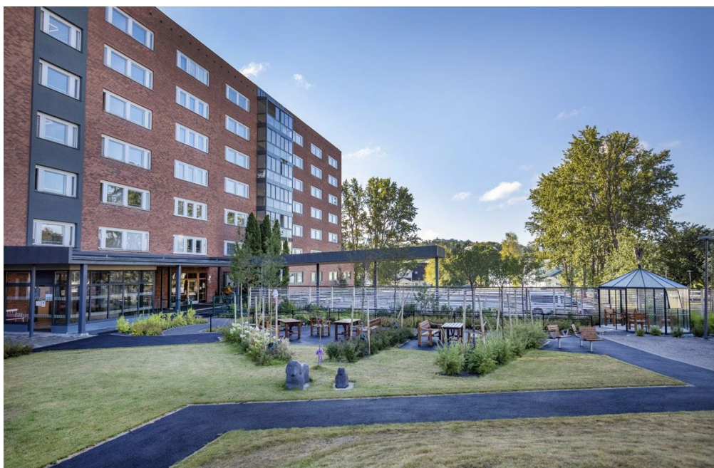
Fastighetsbeteckning: Samariten 1, Region: Stockholm, Segment: Offentlig, Uthyrningsbar yta: 21 942 kvm, Största hyresgäst: Botkyrka kommun, Stockholms läns landsting
