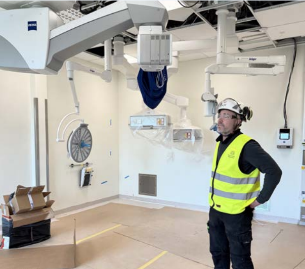
En noggrann projektering och tidsplanering har varit avgörande för att få husets många och avancerade installationer på plats, berättar produktionschef Anders Sandell.
