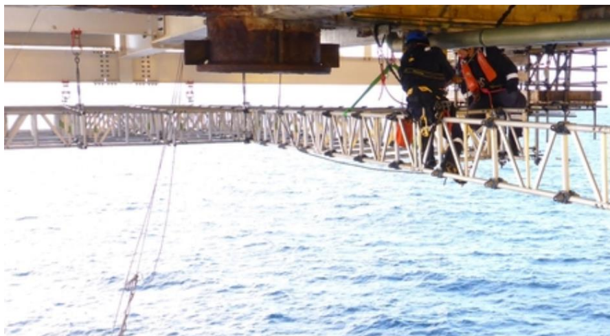
HAKI's TechniSpan system är en plattform för säker åtkomst vid renovering av exempelvis broar och har med sin flexibilitet upp till 75 % färre kontaktpunkter än användning av traditionellt ställningssystem.
