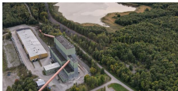
Jan-Matts-dammen i Grängesberg, en del av Grangex apatitprojekt.
