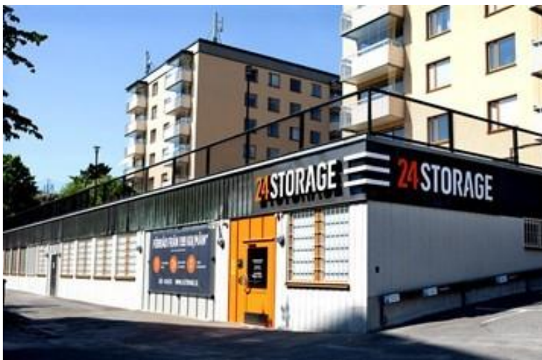
Förråd i ett bostadsområde i Sundbyberg.
