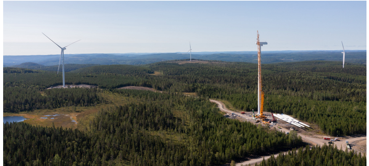
Byggnationen av vindkraftsparken Stor-Skälsjön med 42 verk, 260 MW installerad effekt, är inne i slutskedet.
