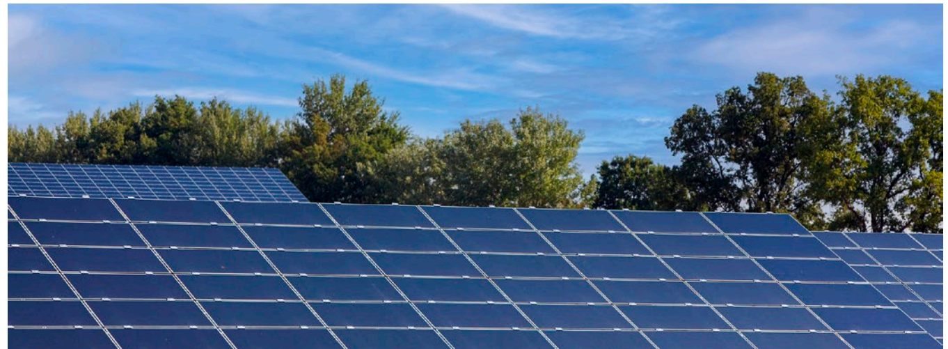
Nyproducerade byggnader förbereds för solcellspaneler. Under 2025 producerade Prismas befintliga solcellsanslaggningar 778 MWh.
