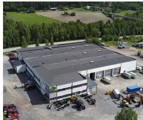
The industrial property Överön 1:25 in Örnsköldsvik.
