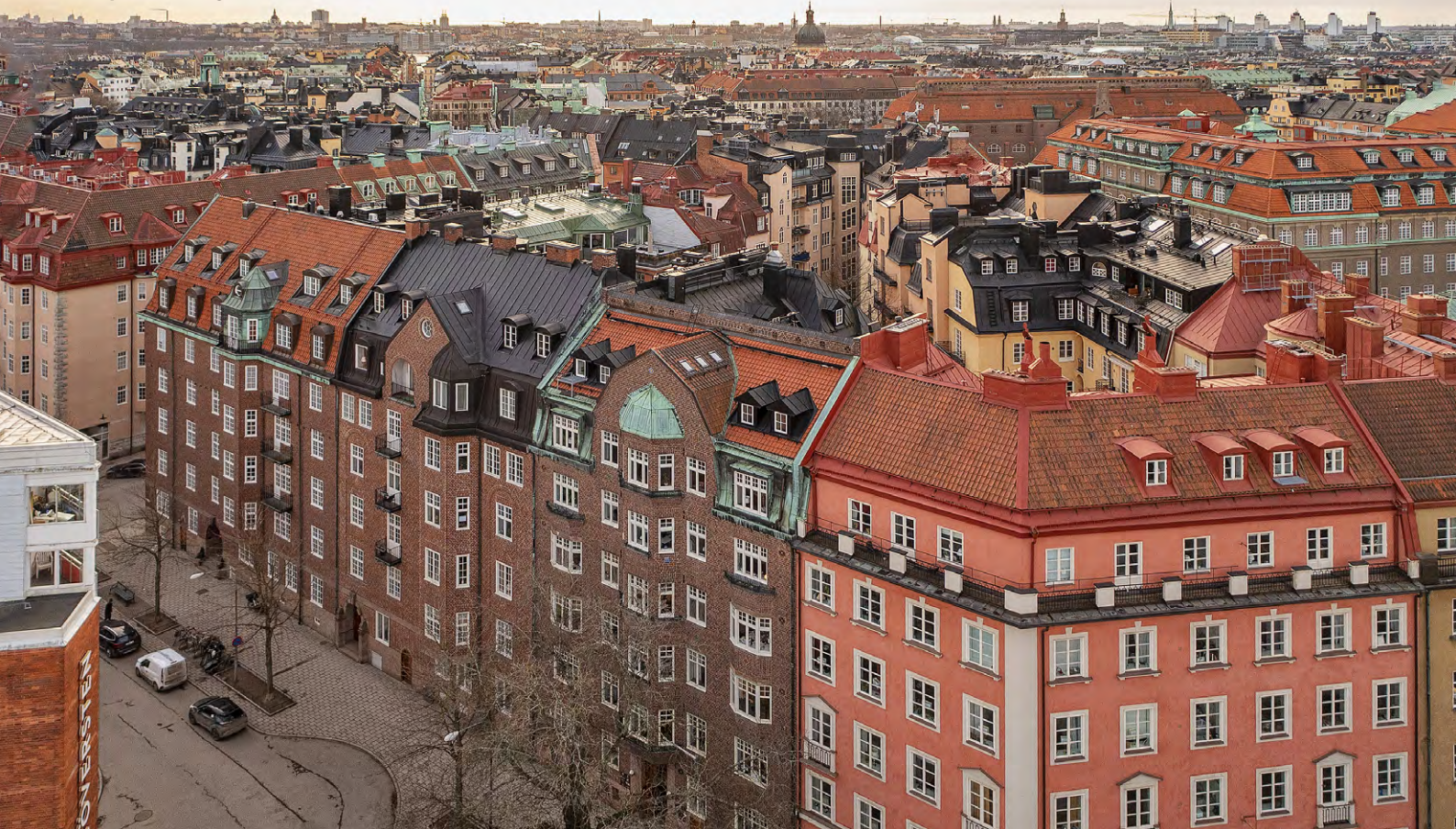
Spiltanhuset på Erik Dahlbergsallén 15 på Östermalm (huskroppen mitt i bild).
