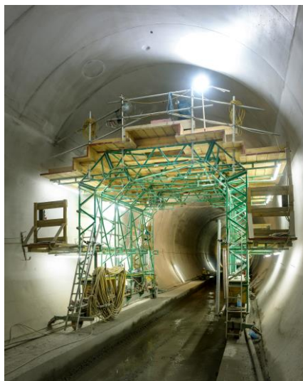
EKRO Bausystems ställningssystem vid tunnelrenovering i Österrike.
