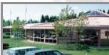
I Sjöuddens industriområde i Växjö förvärvades under 2000 kontorsfastigheten Sjömärket 2.
