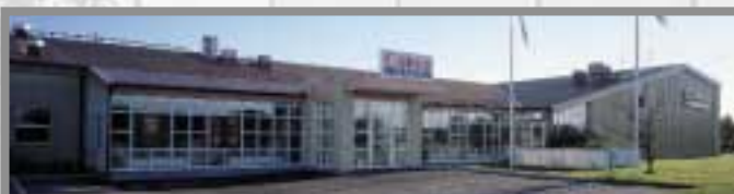
Kontors- och lagerfastigheten Kokillen I i Bäckbyområdet i Västerås.
