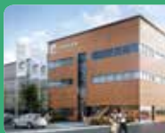
Hisingen logistikpark, etapp 1 GÖTEBORG Nybyggnation logistik
