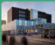
Spiran 12 NORRKÖPING Ombyggnation kontor
