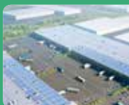
Hisingen logistikpark, etapp 2 GÖTEBORG Nybyggnation logistik
