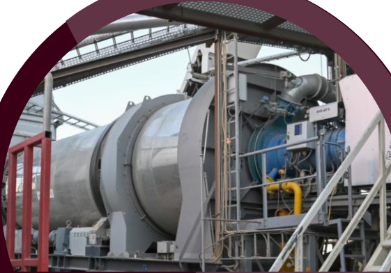
Hydrogen asfaltfabrikk Asfalt Norge
